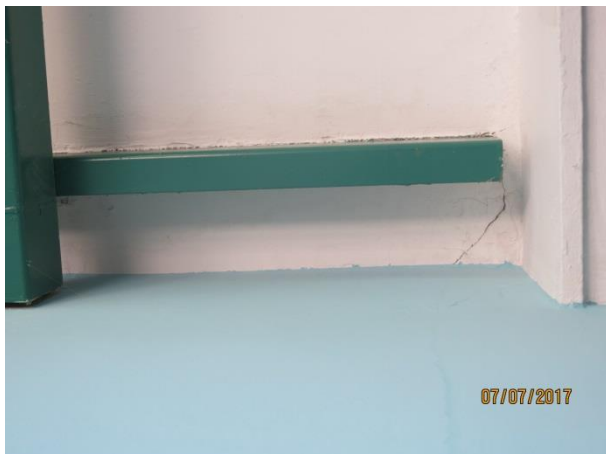
Slika 37: Prečna razpoka na stropu na stiku vmesnega stopnišča s staro šolo - severna stran (nepravilno izvedena dilatacija) R5
