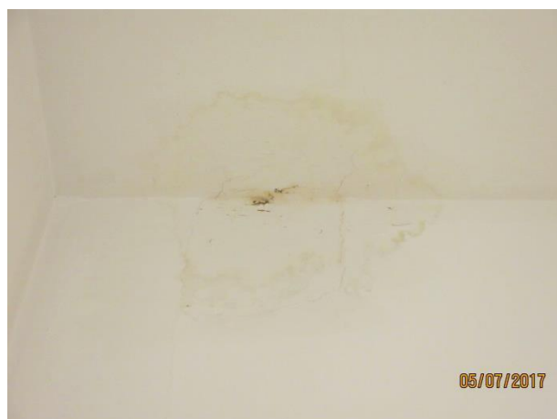
Slika 59: Zamakanje na stropu v sanitarijah (R13) - verjetno poškodovane instalacije
