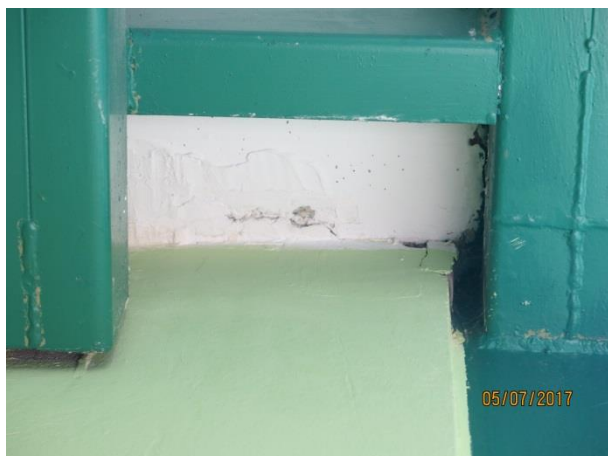
Slika 61: Strižno razpokan omet na stropu na stiku vmesnega stopnišča s staro šolo - južna stran (R14)
