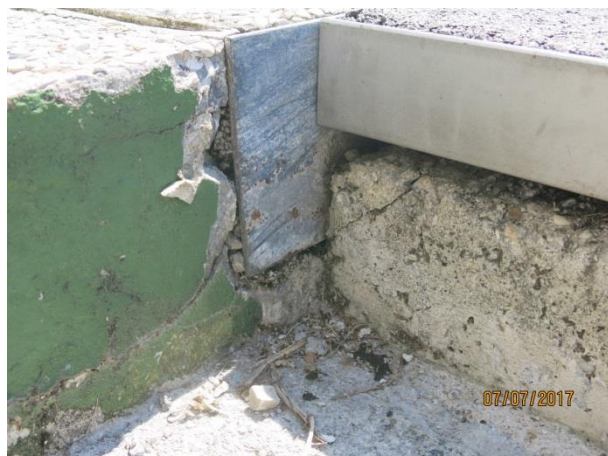
Slika 25: Močnejše poškodovan beton zgornje stopnice
