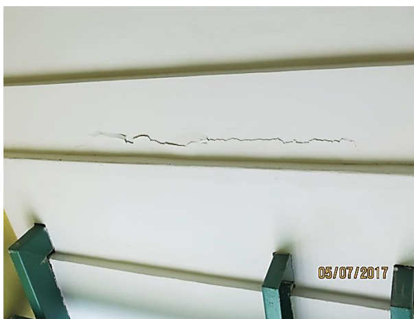
Slika 66: Prečna razpoka na stropu na stiku stopnišča s staro šolo, oplesk odstopa (R1)
