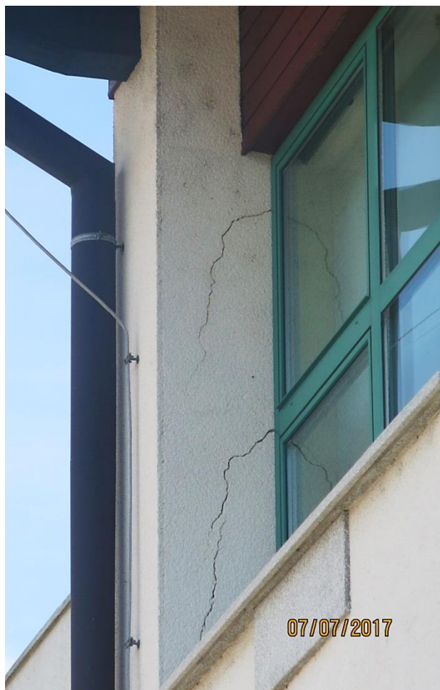
Slika 3: Dve močni poševni razpoki na stebru v osi A v 2.nadstropju
