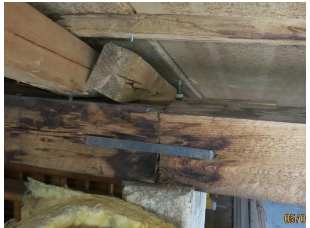
Slika 82: Zarotiran špirovec
