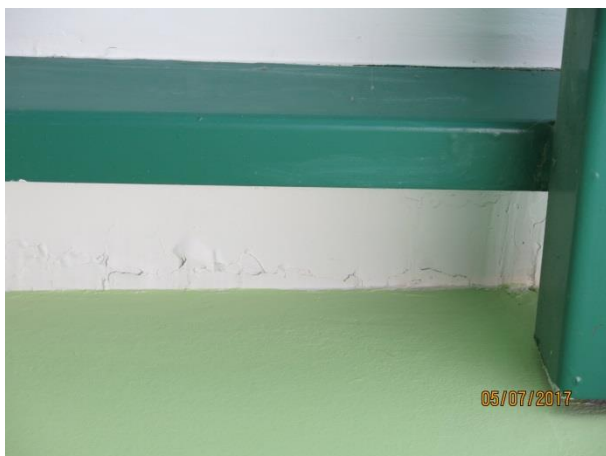
Slika 60: Strižno razpokan omet na stropu na stiku vmesnega stopnišča s staro šolo - južna stran (R14)
