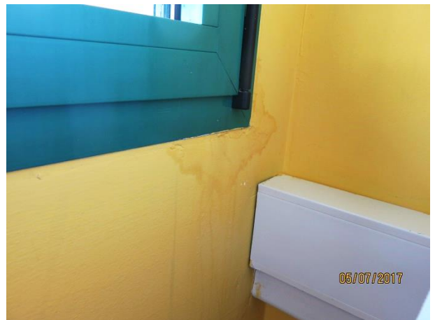
Slika 75: Močnejše zamakanje na vogalih okenskega okvirja (R13)
