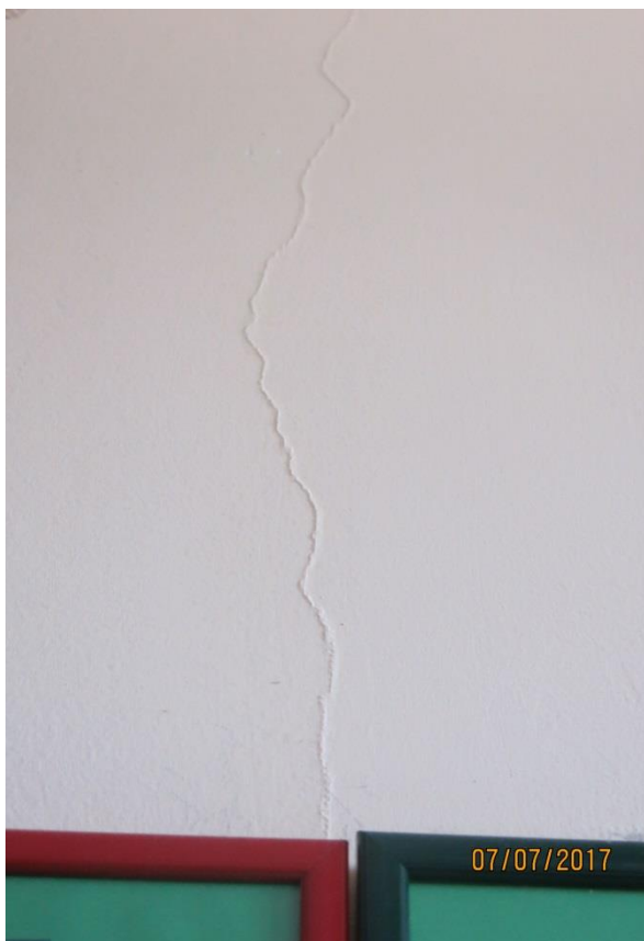
Slika 41: Vertikalna razpoka nad keramično oblogo v jedilnici - se napihuje (R8)
