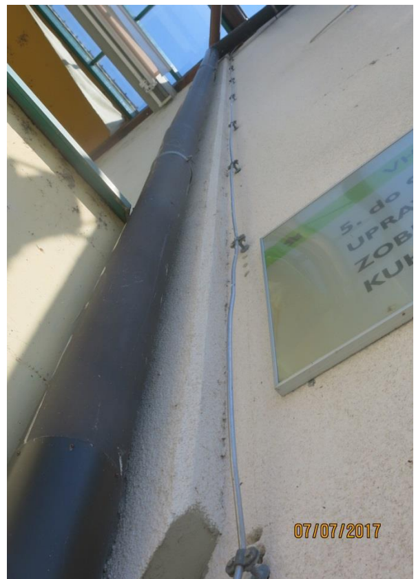
Slika 19: Med obravnavanim vmesnim traktom in staro telovadnico ni dilatacije
