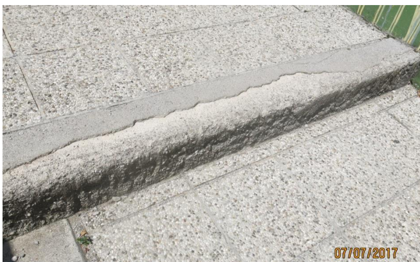
Slika 25: Močnejše poškodovan beton zgornje stopnice
