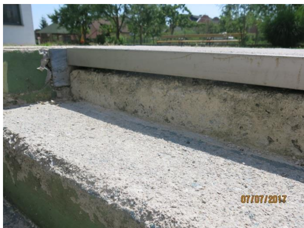
Slika 24: Poškodbe betona na robovih stopnic in ometa
