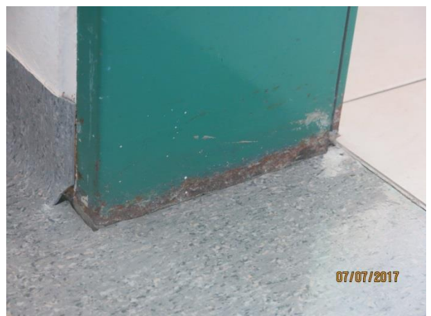
Slika 49: Korozija na kovinskem vratnem okvirju (R18)
