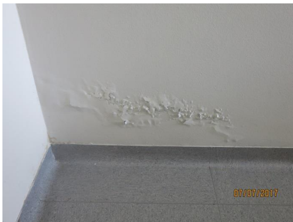
Slika 46: Vlaga in mehurjenje ometa
