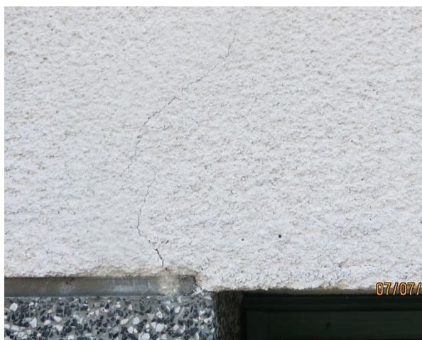
Slika 6: Vertikalna razpoka ob osi A na stiku preklade s stebrom v pritličju
