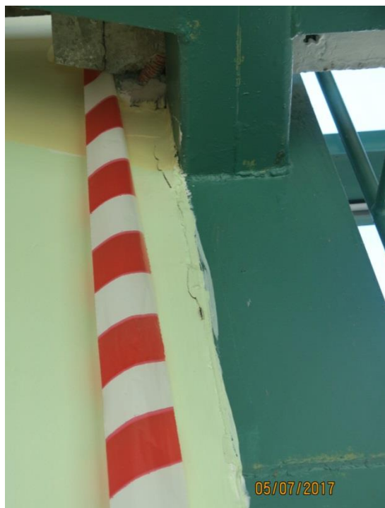
Slika 68: Vertikalna razpoka na stiku stene z jekleno konstrukcijo stopnišča (R3)
