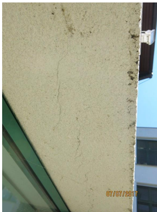
Slika 21: Vzdolžna razpoka na spodnji strani preklade
