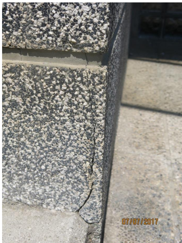
Slika 29: Počena obloga iz pranege betona
