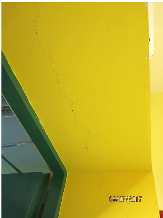
Slika 54: Razpoka vzdolž preklade - verjetno stik med objektoma - ni dilatacije (R5)
