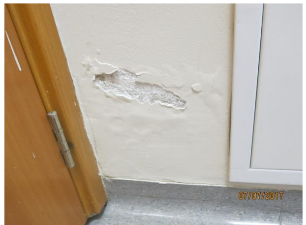
Slika 47: Vlaga in mehurjenje ometa
