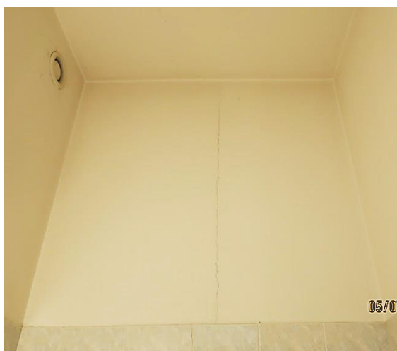
Slika 69: Vertikalna razpoka R6
