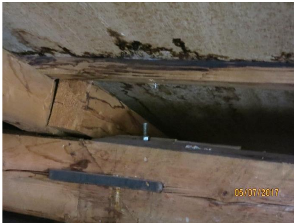
Slika 79: Vidni sledovi zamakanja
