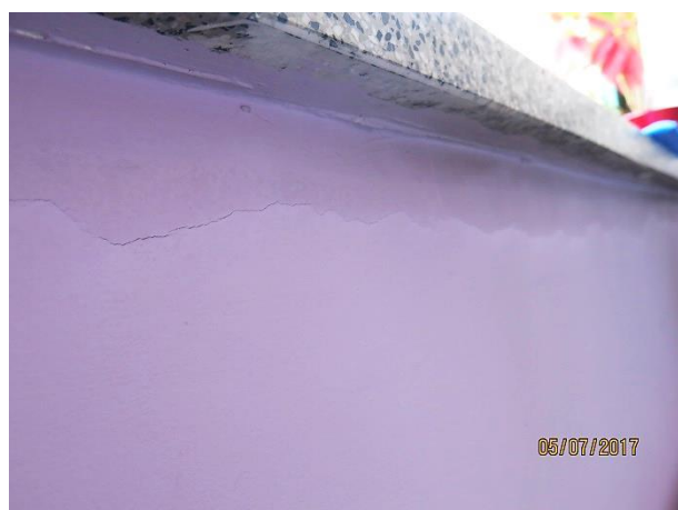
Slika 57: Horizontalna razpoka pod okensko polico (R9)
