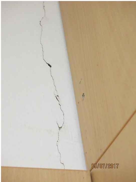
Slika 72: Vertikalna razpoka od obloge do stropa (R10)
