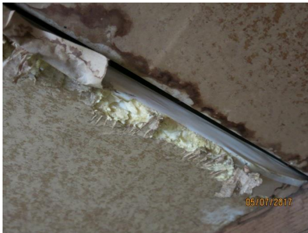
Slika 81: Poškodovana izolacija
