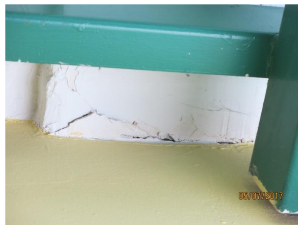
Slika 67: Strižna razpoka na stiku stene in stropa na stiku stopnišča s staro šolo - južna stran (R2)
