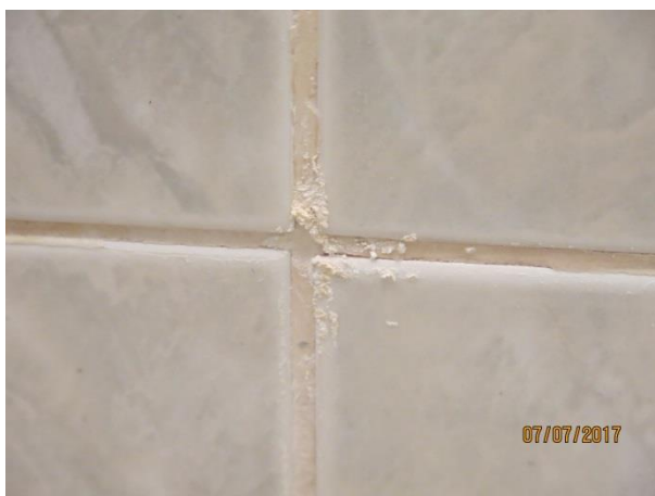
Slika 48: Izločanje sige med spojniciami keramične obloge
