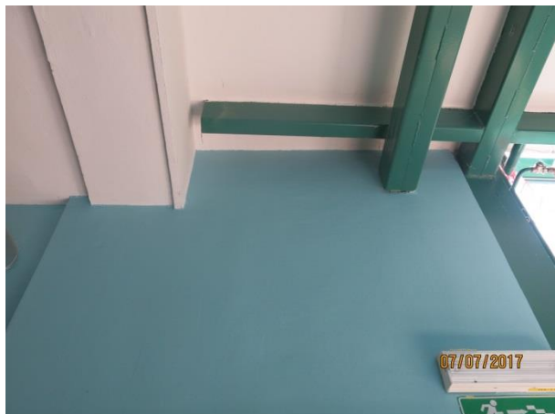
Slika 38: Prečna razpoka na stropu na stiku vmesnega stopnišča s staro šolo - južna stran (nepravilno izvedena dilatacija) R4
