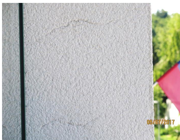
Slika 5: Horizontalne razpoke na stebru v osi B v 2.nadstropju
