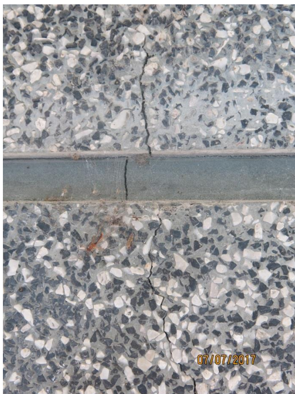
Slika 30: Vertikalne razpoke na fasadni oblogi iz pranege betona -na več mestih
