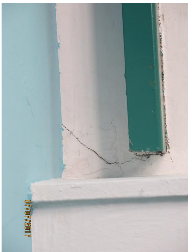
Slika 39: Prečna razpoka na stropu na stiku vmesnega stopnišča s staro šolo - severna stran - detajl (R5)
