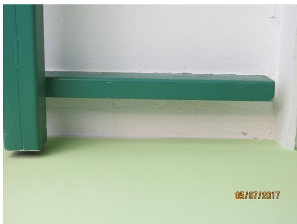
Slika 63: Že izvedena popravila na stiku vmesnega stopnišča s staro šolo - severna stran (R15)
