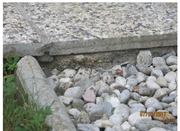
Slika 13 in 14: Posedanje zunanje ureditve ob objektu med osmi F in G za ca 5 cm
